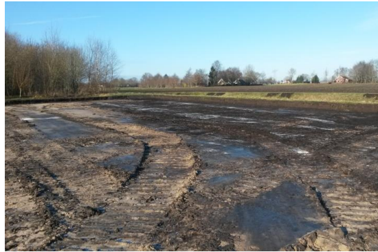
Afbeelding 3.4 Aangelegde werkstraat nabij Gieterveen met op de rechterfoto de overgang van zand naar veen zichtbaar.
