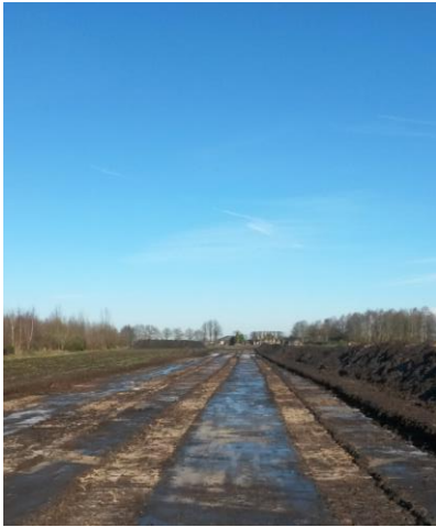
Afbeelding 3.4 Aangelegde werkstraat nabij Gieterveen met op de rechterfoto de overgang van zand naar veen zichtbaar.
